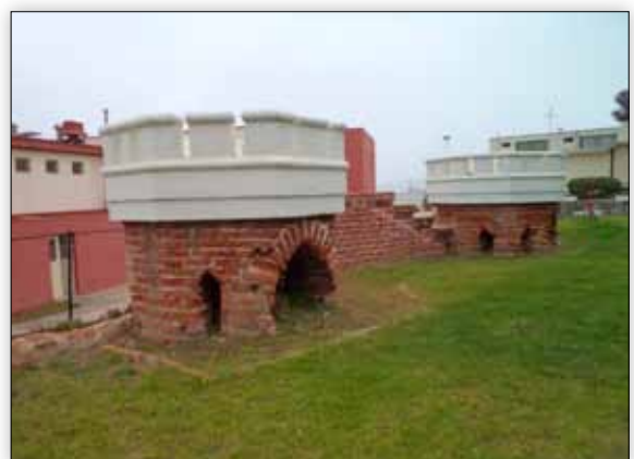
Interior del túnel y torreones que coronan el frontis.
