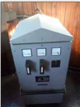
Fanal de Emergencia.
