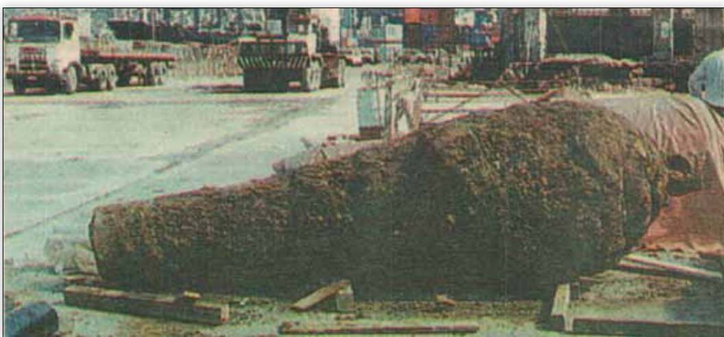
Cañón Armstrong de 300 libras en el sitio mismo de la excavación.
