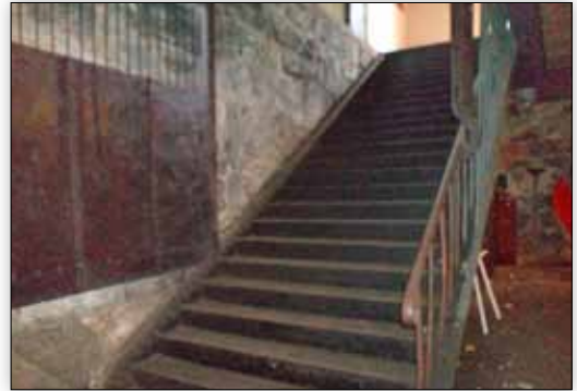
Escalera de acceso.
