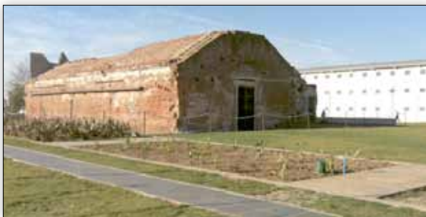
El polvorín antes de su remodelación. (Fotografías del autor en visita 2011).
